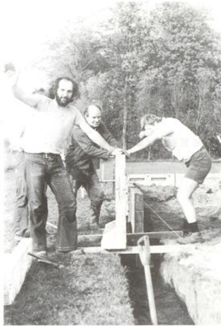
VAN FUNDERING TOT DAK.... MET EIGEN AANPAK !
